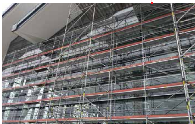
Prace przy fasadzie budynku lotniska
